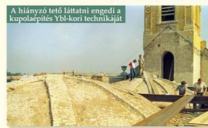
A hiányzó tető láttatni engedi a kupolaépítés Ybl-kori technikáját
